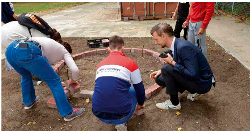
Bau der Feuerstelle
